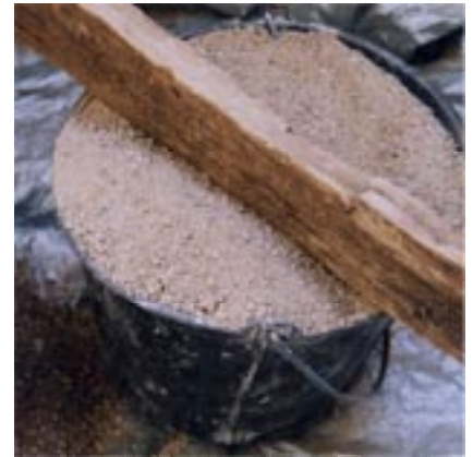
20 - Mesure en seaux arrasés
